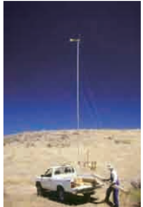
Paul Gipe se ha convertido en un embajador de la eólica doméstica y fácil de instalar. En la foto inferior puede verse después de haber instalado una pequeña turbina con una torre mástil con tensores sin utilizar ninguna grúa u otro tipo de máquina especial.
