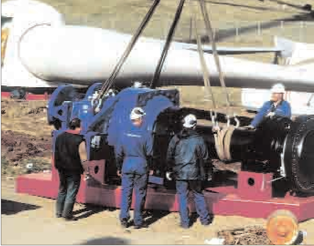
El estudio de la Universidad de Zaragoza sobre el sector eólico estima que, a finales de 2005, Aragón contará con 73 parques y una potencia instalada cercana a los 1.800 MW, lo que significa una media aproximada de 25 MW por parque. En las imágenes, instalación de un parque con aerogeneradores de NEG Micon, que tiene en la comunidad autónoma aragonesa uno de sus centros de producción.
