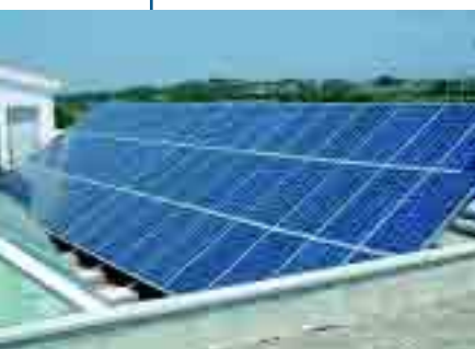
Los paneles solares con conexión a red instalados en el Ayuntamiento de San Antonio de Benagéber, en Valencia, producirán al año 9.100 kWh, aproximadamente el consumo de un edificio de esas características.
