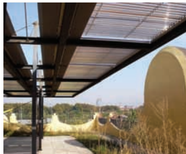
En una de las fachadas, una instalación fotovoltaica se encarga de producir electricidad. Los 32 módulos centrales son autónomos y los 52 laterales están conectados a red.
