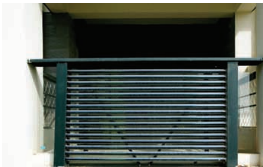
En la página anterior, ejemplo de integración de tubos de vacío en las barandillas de las terrazas de un edificio. Junto a estas líneas, detalle de la barandilla.
