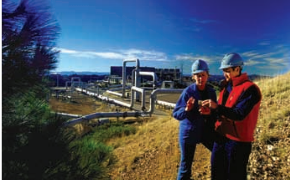
Central geotérmica "The Geysers", en Middletown, California, EE.UU., la más grande del mundo, con una potencia de 750 MW y 21 centrales de generación. Abajo, central en Valencia, Negros Oriental, Filipinas.
