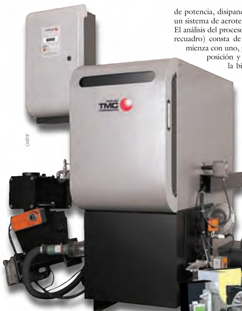
Una de las calderas con las que va a operar el Centro Tecnológico Cartif es la Frohling Turbomatic de 28 kW (ambas imágenes). El Grupo Nova Energía, que colabora con Cartif, ha suministrado e instalado esta caldera en el laboratorio de biomasa de Valladolid.
