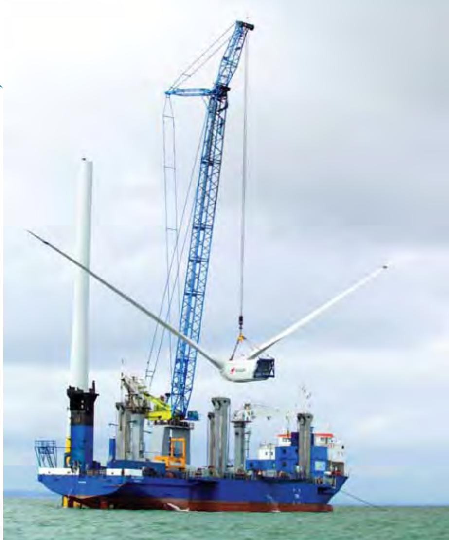
Descarga para su instalación de un aerogenerador en el parque eólico de Kentish Flats. En página siguiente, parque eólico de North Hoyle.
