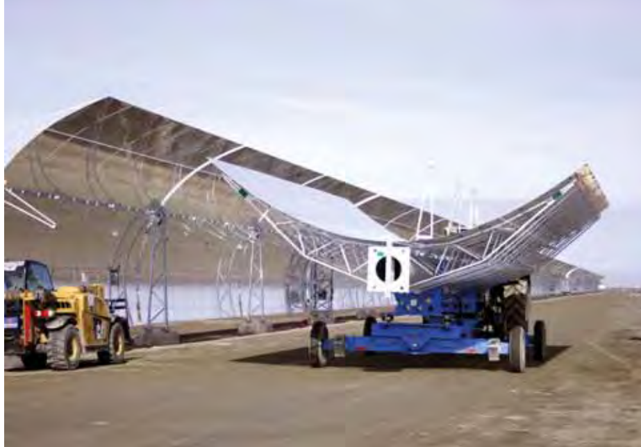
Siemens instala sus canales parabólicos –completamente montados– sin emplear en sus operaciones grúas, lo que le permite trabajar con vientos de hasta 50 kilómetros por hora
