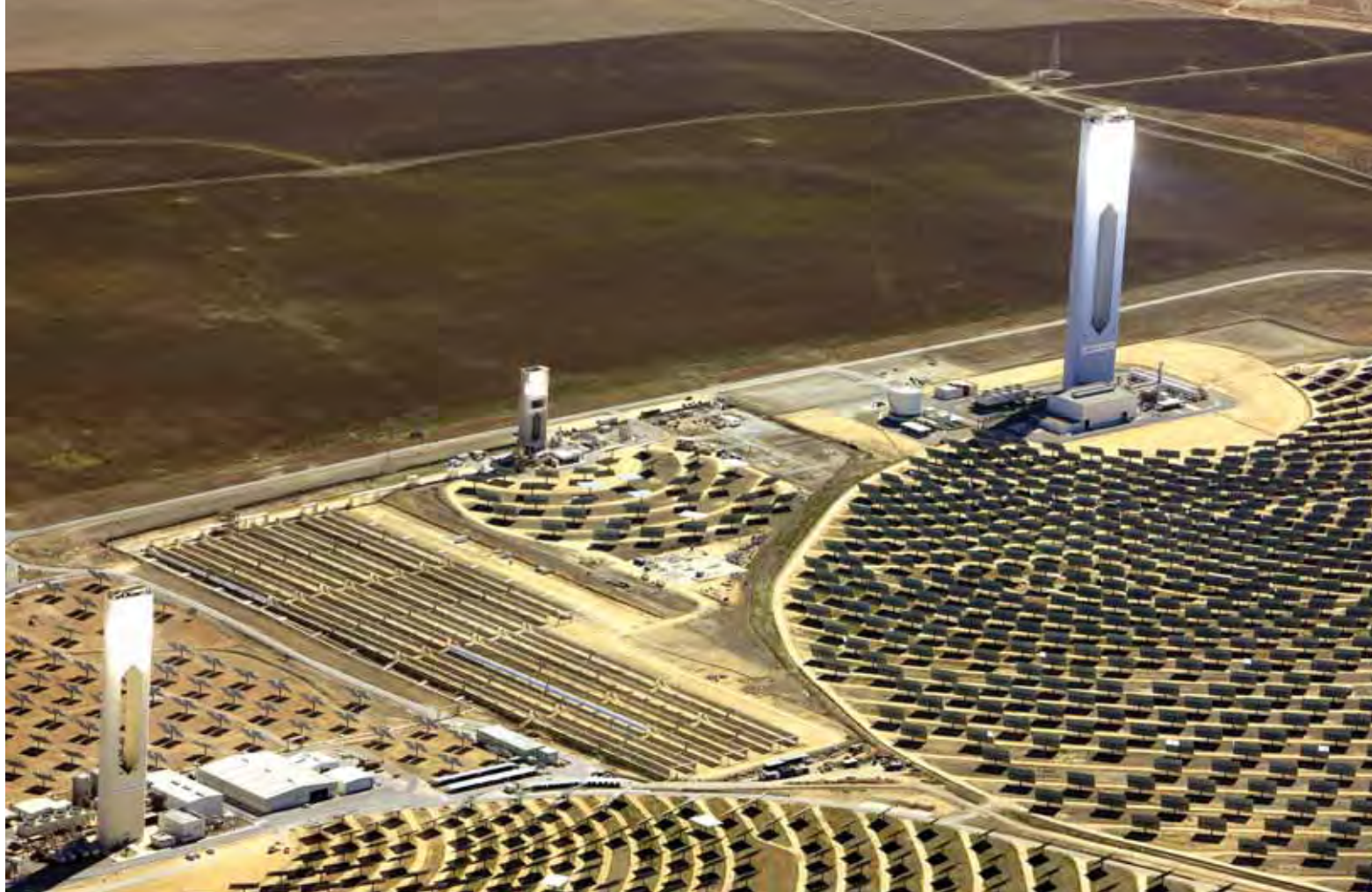
Tres plantas de torre operando en la Plataforma Solúcar en Sevilla.
