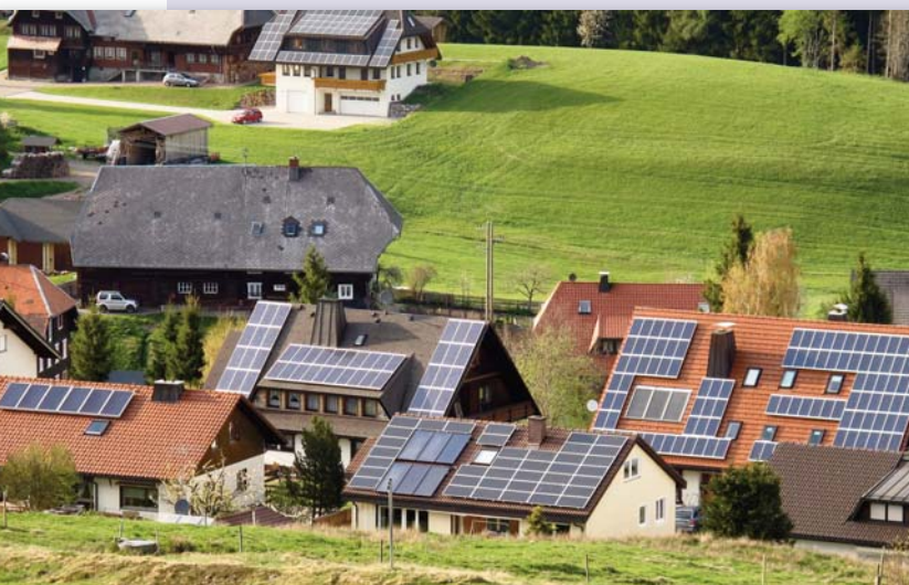
Viviendas con instalaciones fotovoltaicas en un pueblo de Alemania.
