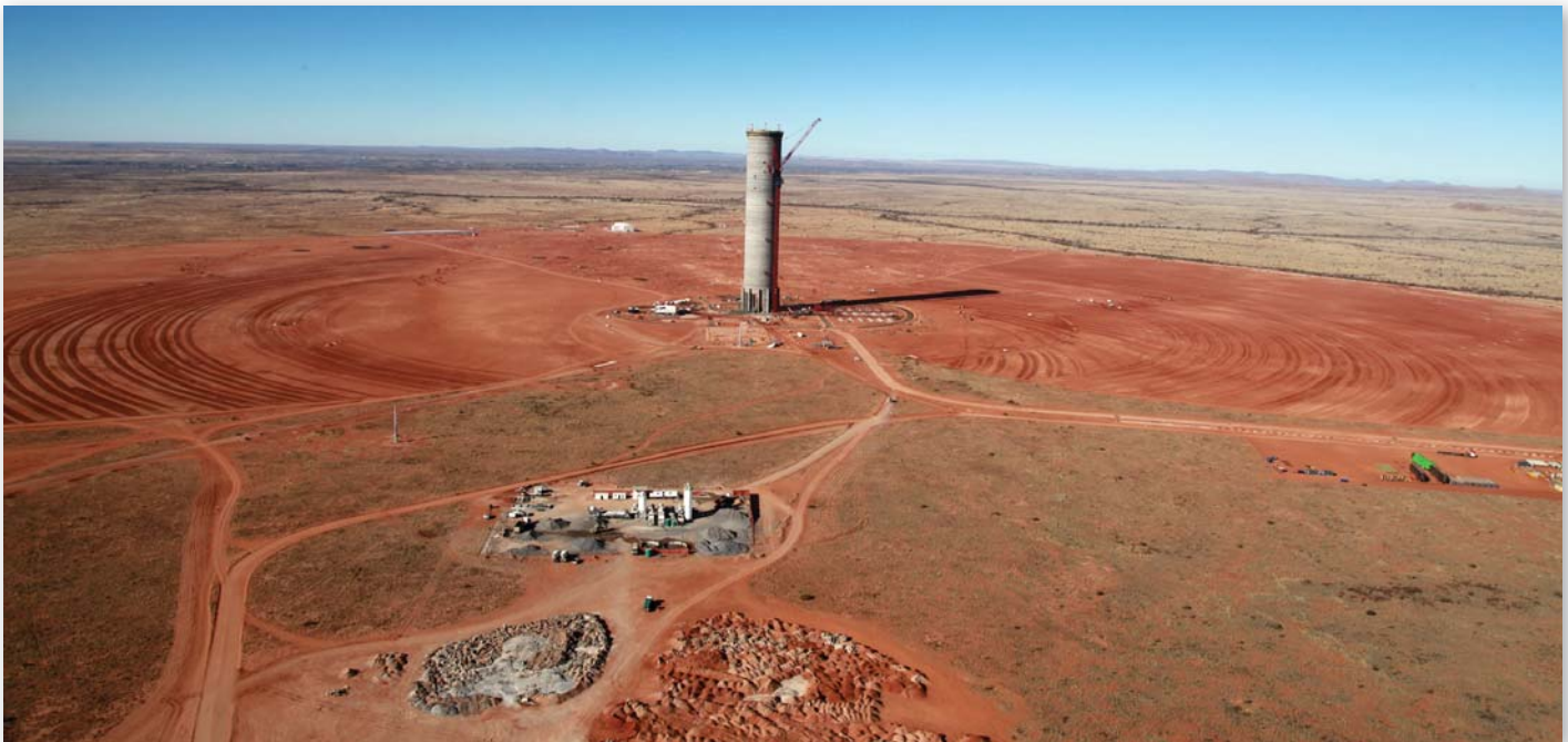
Abengoa está construyendo en Sudáfrica la central Khi Solar One, de 50 MW y dos horas de almacenamiento. Será la primera planta de tecnología de torre que la multinacional sevillana desarrolla fuera de España.
