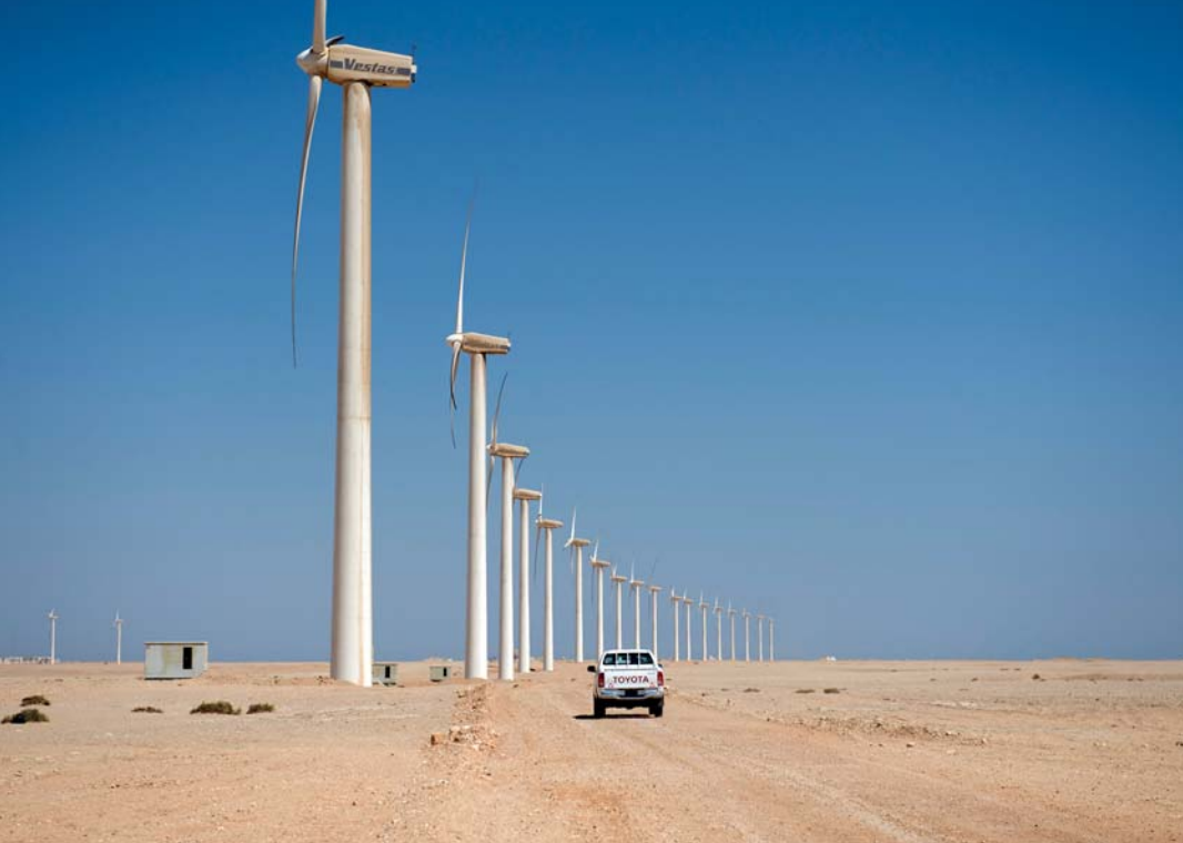
Parque eólico Zafarana en Egipto. A la derecha, Construcción del parque solar Droogfontein en Sudáfrica.
