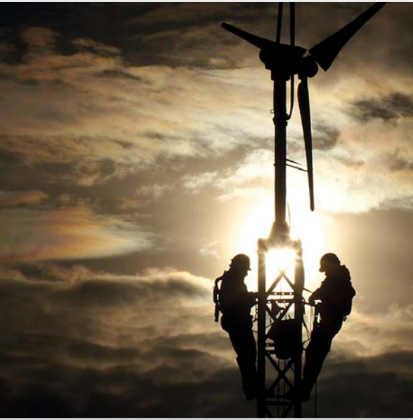
As Corcerizas, el emblemático centro de educación ambiental de Amigos de la Tierra, tiene una microturbina hidráulica, una instalación solar fotovoltaica (cinco kilovatios), una serie de baterías estacionarias, un par de calderas de biomasa, una instalación solar térmica y, desde hace apenas unos meses, un miniaerogenerador (fotos), que financiaron con el premio de 24.800 libras que obtuvo ese centro en un certamen internacional organizado por Hostelling International , que es la red mundial de asociaciones de albergues juveniles. Abajo y en la otra página, dos actos reivindicativos de la asociación.
