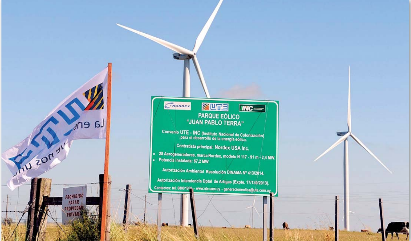
Parque Eólico Juan Pablo Terra. Abajo, en el recuadro, construcción del parque Eólico de Beberibé, en Ceará, Brasil.
