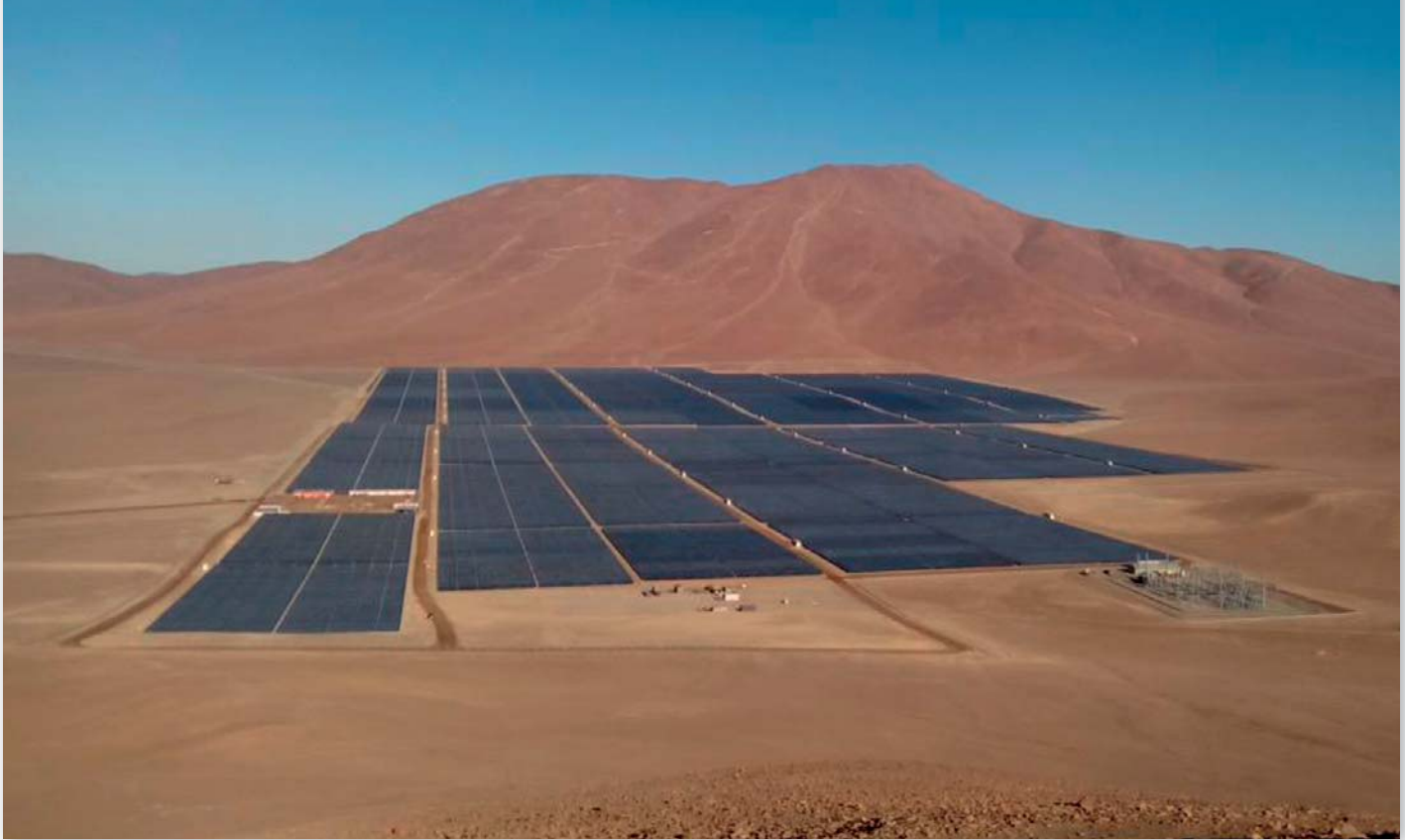
Arriba planta solar Javiera, de 64 MW, en la región de Atacama. En la página anterior, imagen del complejo solar Atacama I de Abengoa.
