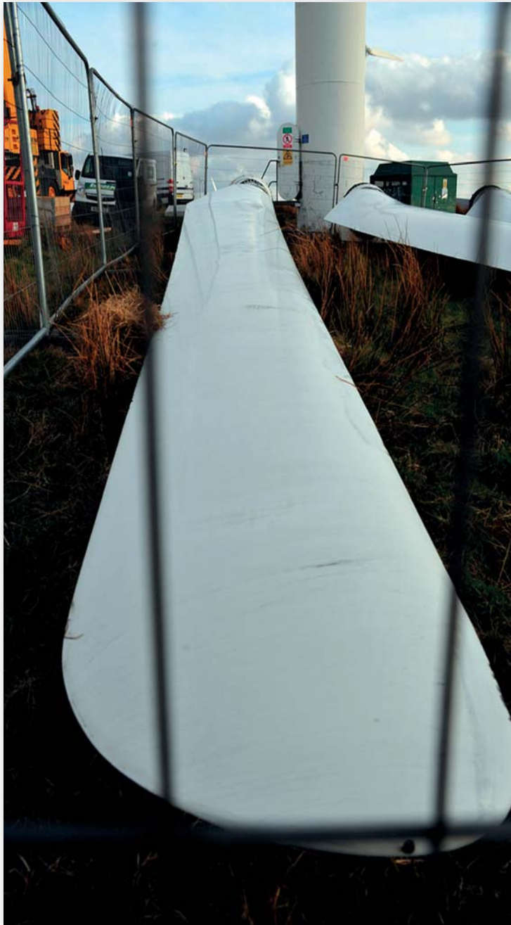
Palas desmontadas en el parque eólico de Coal Clough.
