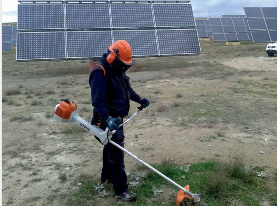
Labores de desbroce e imagen termográfica. Los estudios termográficos son claves en el mantenimiento predictivo ya que permiten descubrir distintas anomalías en los paneles. En la página siguiente, operaciones de limpieza en paneles y cuadros eléctricos.
