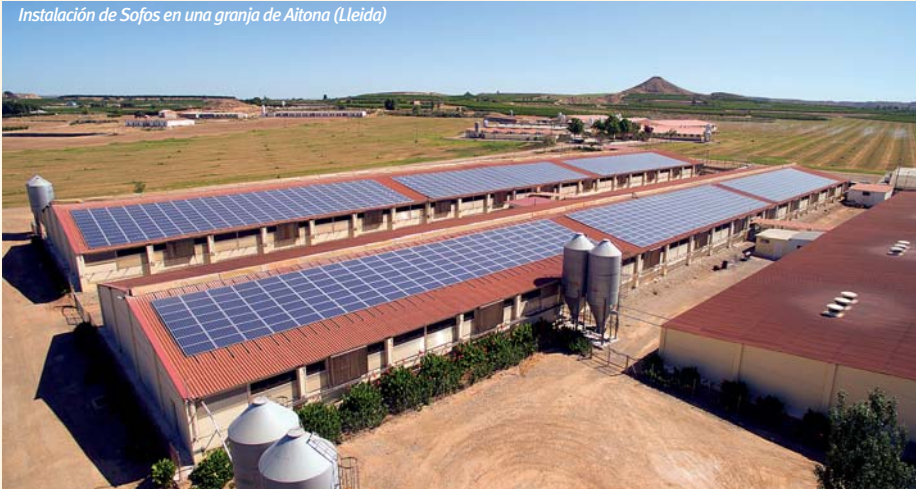
Instalación de Sofos en una granja de Aitona (Lleida)
