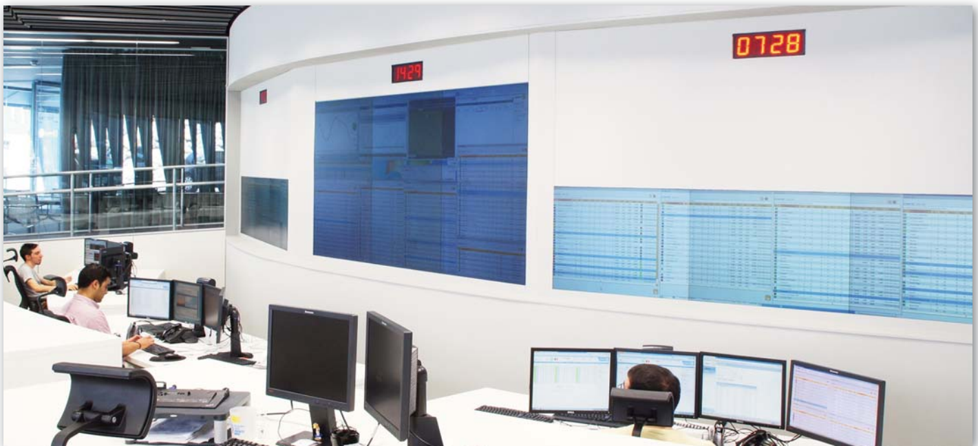
Centro de control de Gamesa en Sarriguren (Navarra), en donde opera más de 400 parques eólicos en todo el mundo.
