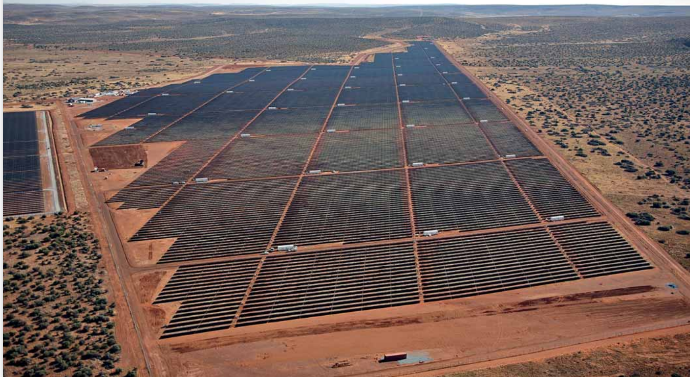
La planta Jasper Solar, en Sudáfrica, tiene 96 MW de potencia, lo que la convierte en la más grande del continente africano.
