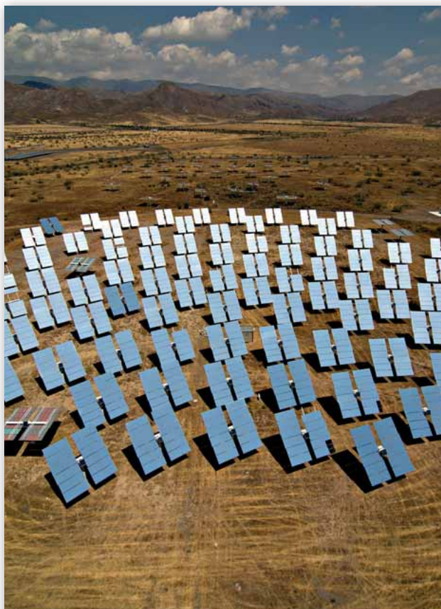
Vista general del campo de heliostatos CRS de la Plataforma Solar de Almería.
