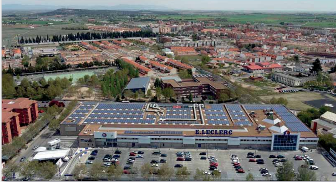
Instalación sobre cubierta en el centro comercial Leclerc en Ciudad Real, de I+D Energías.
