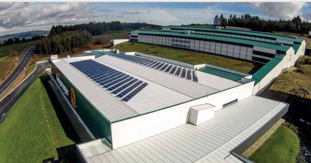
Instalación fotovoltaica en Granja Campomayor, Lugo de La Eléctrica Lugo (Grupo Elektra).
