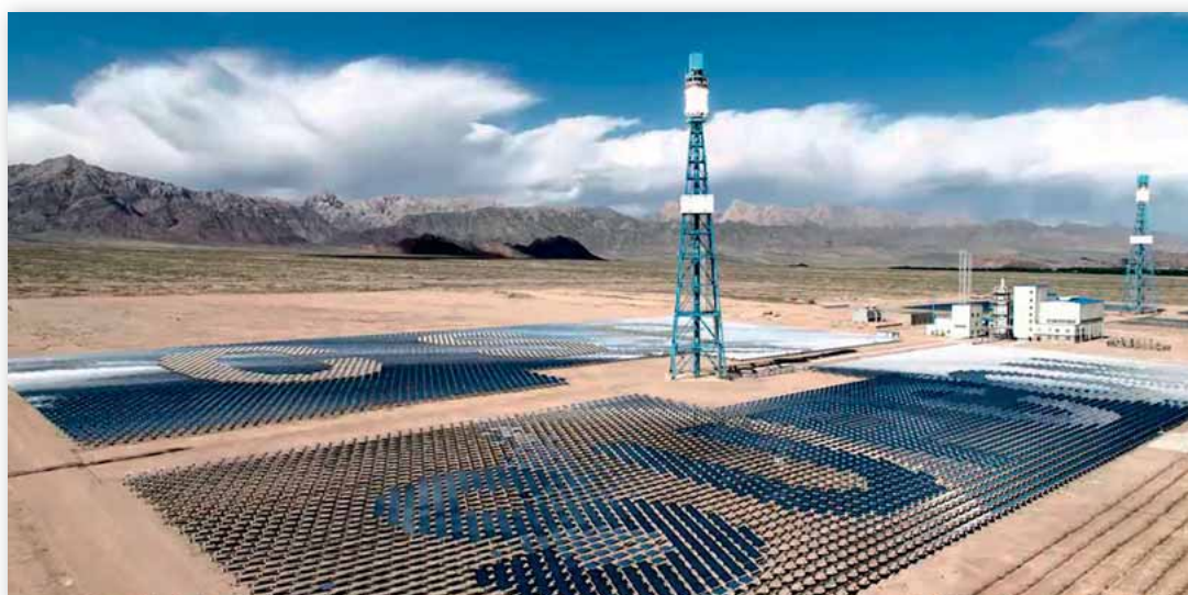
A la izquierda, Centro Nacional de I+D de Tecnologías Energéticas, centrado en la investigación termosolar. A la derecha, proyecto inicial de la planta de Qinghai Delingha, ahora en construcción, que llegará a tener una potencia de 50 MW.
