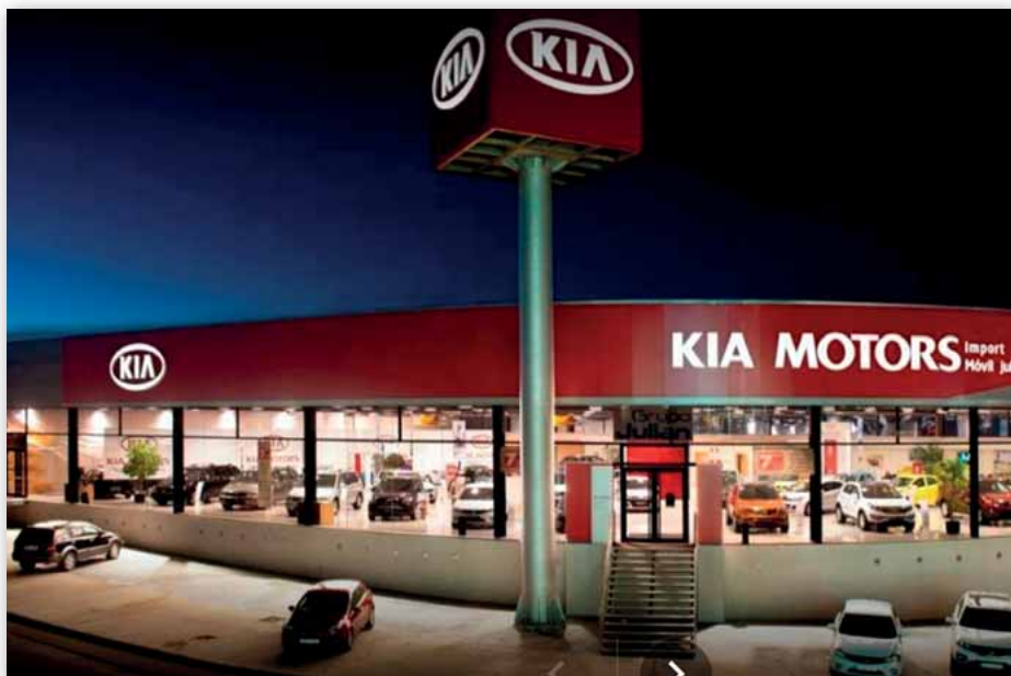
Concesionario de KIA Motor en Burgos que ha cambiado gas natural por biomasa. En la página siguiente, BiomBox, cabina para la caldera de biomasa instalada por Imartec en la Residencia Millet Park, en Ametlla del Valles (Barcelona).
