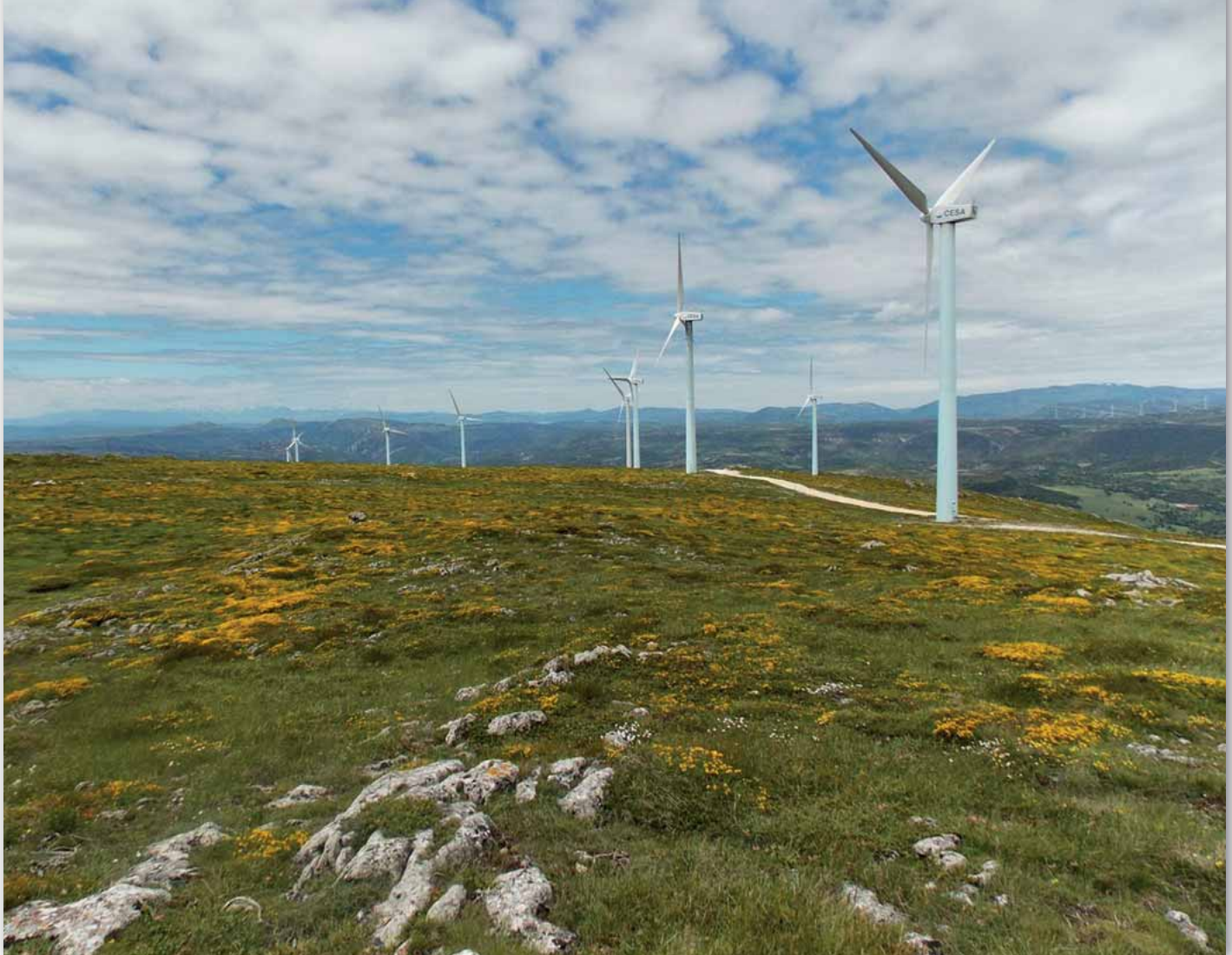
Parque eólico del Grupo Jorge en Páramo de la Poza.
