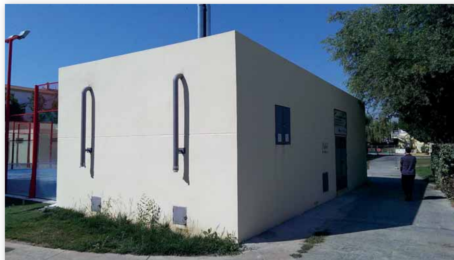
Planta de producción de calor con biomasa para la calefacción del distrito, en Huétor-Tájar (Granada), que surte de calor a la piscina cubierta climatizada, a los tres edificios del colegio público San Isidro, al pabellón municipal de deportes y al Centro de Asuntos Sociales.
