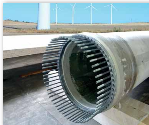
Figura 3. La unión en 'T-Bolt' compuesta por la tuerca de barril y el perno tiene enormes ventajas frente a la solución del fabricante.
