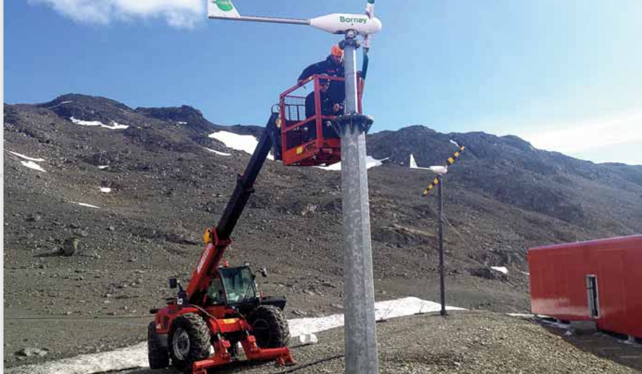
Tareas de mantenimiento en un aerogenerador Bornay 3000 en la Base Española Juan Carlos I de la Antártida. Debajo, imagen de un Wind+ 25.2.
