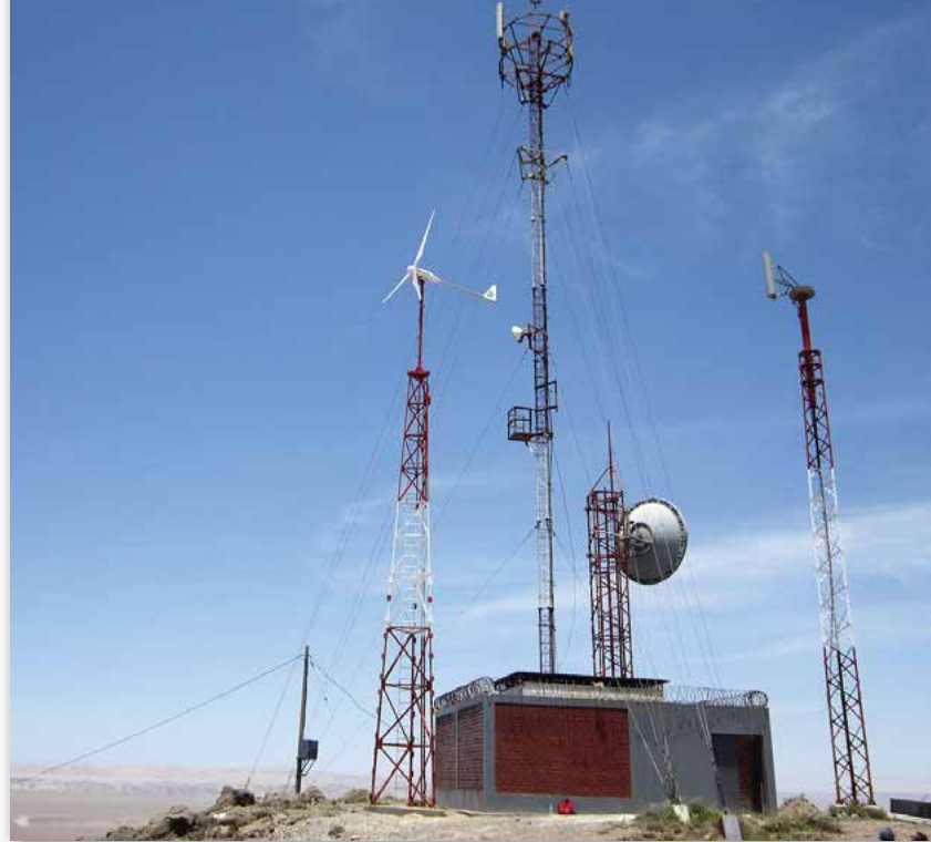
Instalación híbrida eólico-solar para un bombeo de agua en Almansa (Albacete). Entre las antenas de esta estación de telecomunicaciones en Perú puede verse un aerogenerador Bornay Wind+ 25.3.
