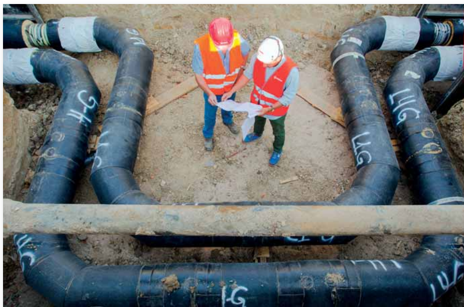
Veolia está instalando en estas fechas una red de calor de biomasa para 398 viviendas en Valladolid.
