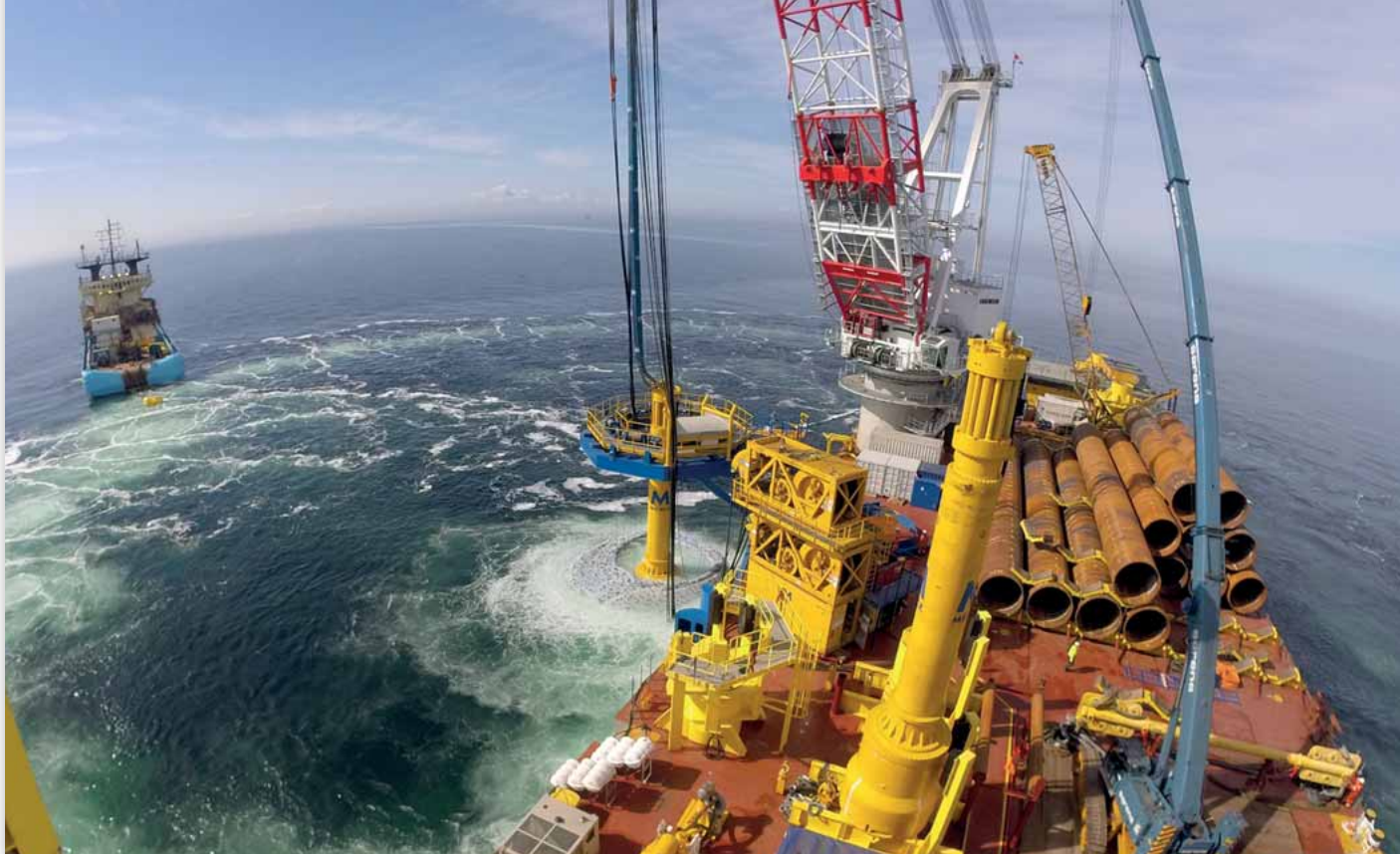
El parque Wikinger, que se construye en aguas alemanas del mar Báltico, está promovido por Iberdrola y en él trabajan también otras empresas españolas.
