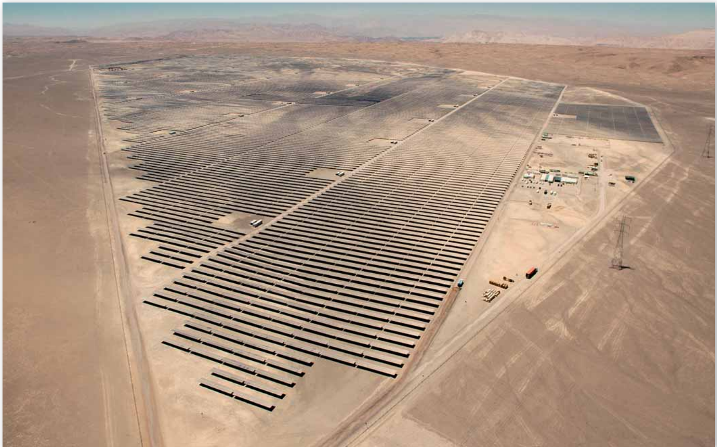
Parque fotovoltaico Rubí, la planta solar fotovoltaica más grande del Perú, con una capacidad instalada de 180 MW.
