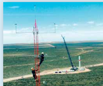
Trabajos de montaje de instrumentación en una torre meteorológica, en un ensayo de curva de potencia.
