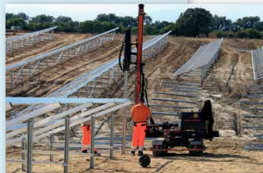
Planta solar durante la fase de construcción en Francia.
