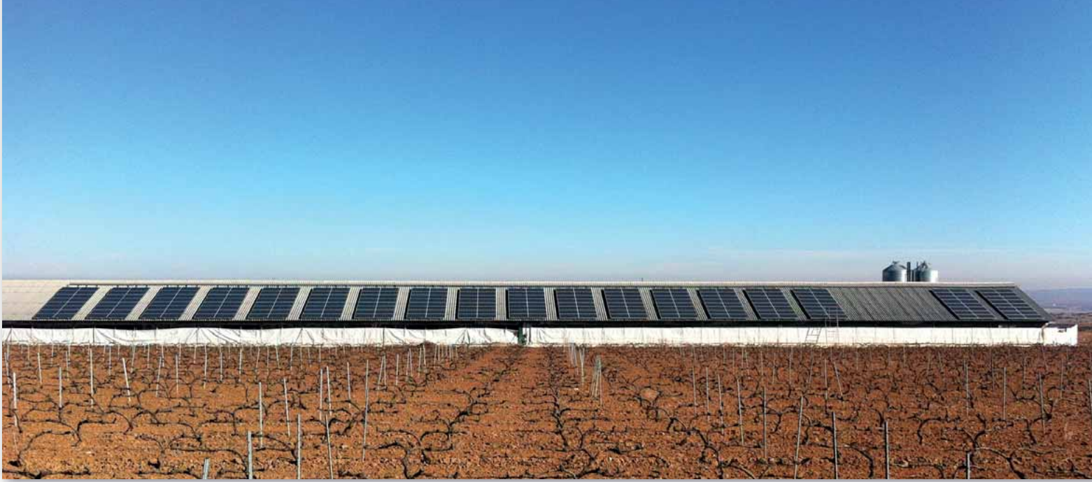
Arriba, bombeo solar de 55 kW en viñedo. Abajo a la derecha, autoconsumo fotovoltaico de 20 kW conectado a red interior del cliente para granja de porcino.
