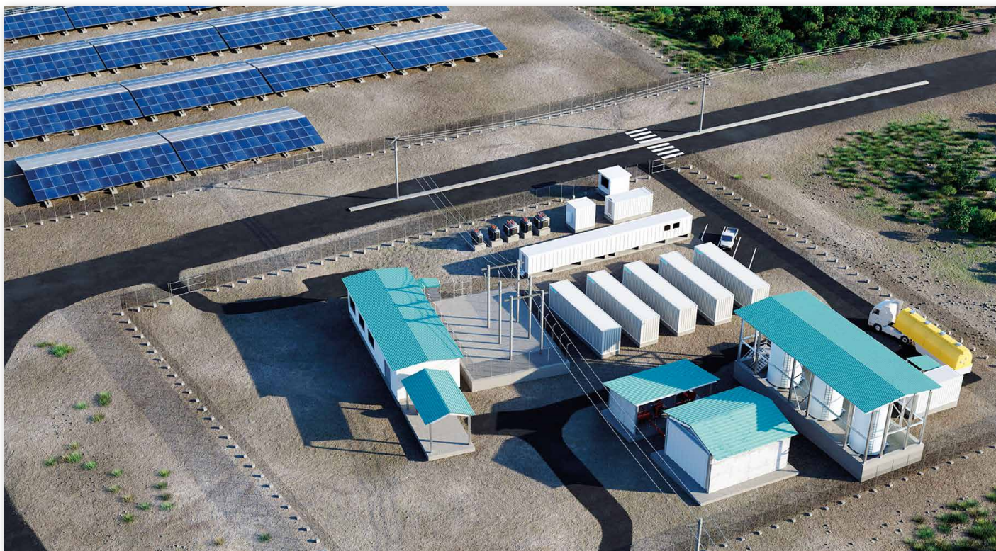
Arriba, planta híbrida en la isla Isabela, en Galápagos, Ecuador, con 84 módulos de almacenamiento. Debajo, Aura Solar III en Baja California, México, con un sistema de almacenamiento de 10.5-5.6 MW-MWh
