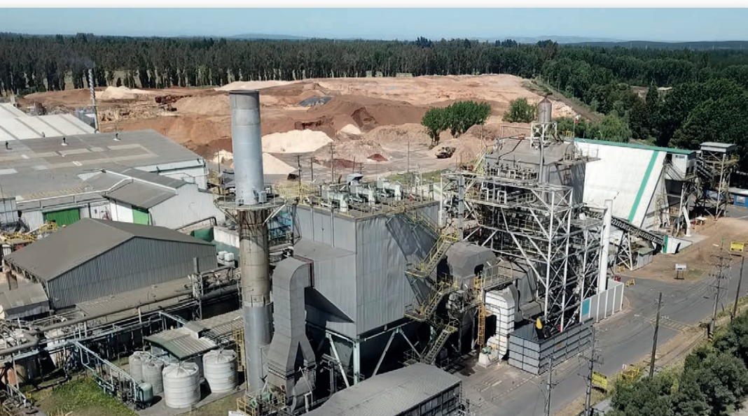
Arriba, semirremolque de piso móvil especial para el transporte de biomasa. A la izquierda, planta de cogeneración por biomasa en Neomas (Chile), que genera electricidad y vapor
