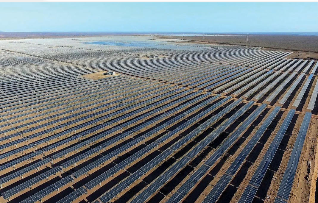
El Parque Solar São Gonçalo, situado en el Estado de Piauí, ostenta el récord de contar con más de 2,2 millones de paneles solares. Además, está desempeñando un papel clave en la recuperación verde de Brasil
