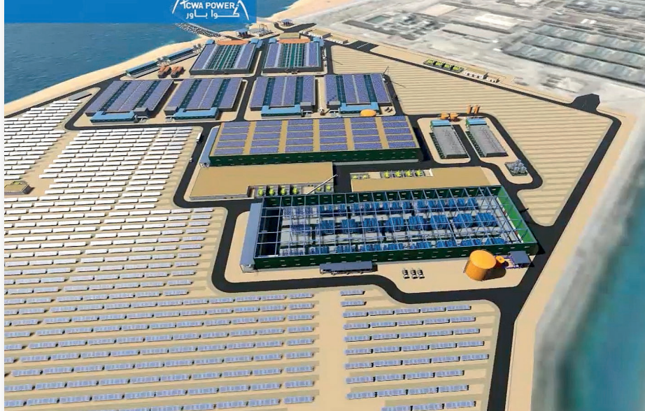
Diseño de la planta Taweelah, en Abu Dhabi (ósmosis inversa con solar solar fotovoltaica). Fuente: ACWA Power
