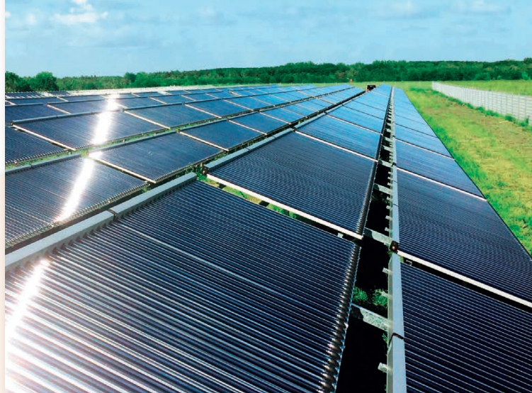
Sistema de calefacción urbana solar con 18.732 \text{m}^2 de colectores de tubos de vacío en Greifswald, Alemania
