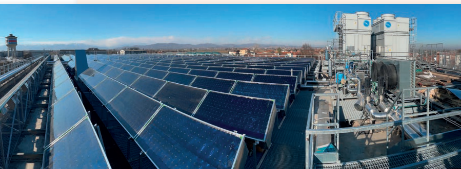
Sistema de calor de proceso solar para Martini & Rossi con una capacidad de 0,42 MWth y equipado con colectores planos de alto vacío en Turín, Italia
