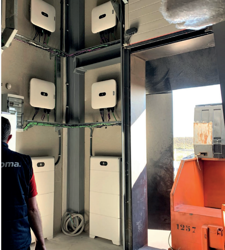
Instalación realizada por Cubierta Solar de un sistema de baterías de 90 kWh. Son la avanzadilla de lo que está por venir: megabaterías de 2 MWh que podrían abastecer a 500 hogares
