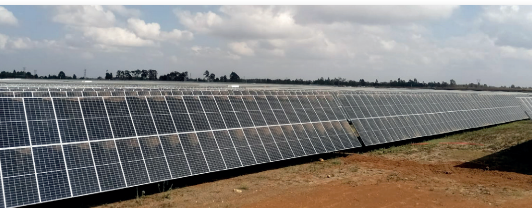
Planta de Kesses, en Kenia. Tiene una potencia de 55 MW y utiliza el modelo de seguidor Vanguard 2P
