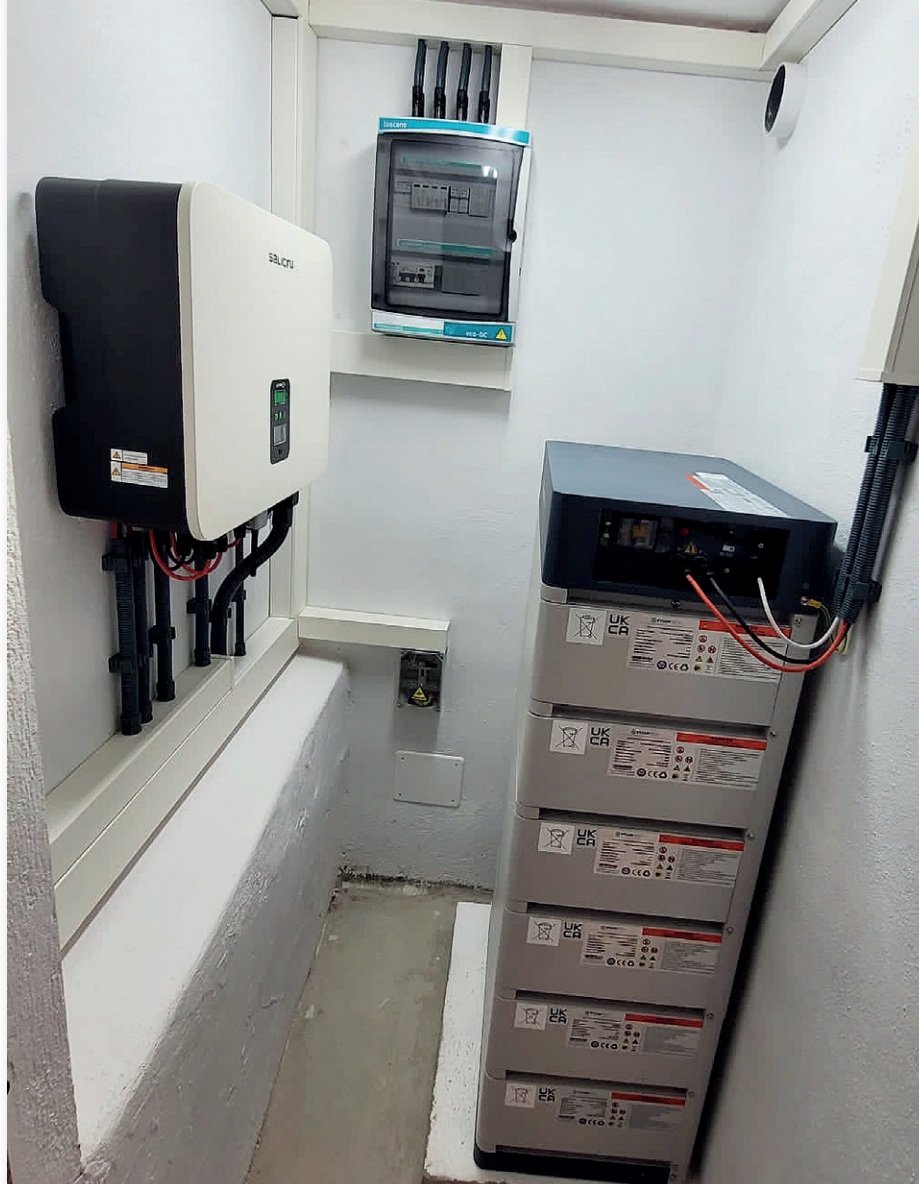
Instalación de 8 kW de potencia en Ibiza, con un inversor híbrido monofásico Salicru Equinox y baterías de litio Pylontech
