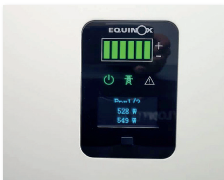
Instalación de 8 kW de potencia en Ibiza, con un inversor híbrido monofásico Salicru Equinox y baterías de litio Pylontech
