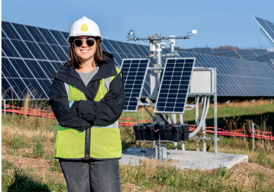
Julia Ravelson, Product Manager de NRG Systems, junto a un sistema Flare Solar Resource Monitoring (SRM), que garantiza un rendimiento óptimo al detectar ineficiencias a nivel de módulo, array y sistema completo. Debajo, el NRG R2, un piranómetro que proporciona datos de irradiación solar de gran precisión
