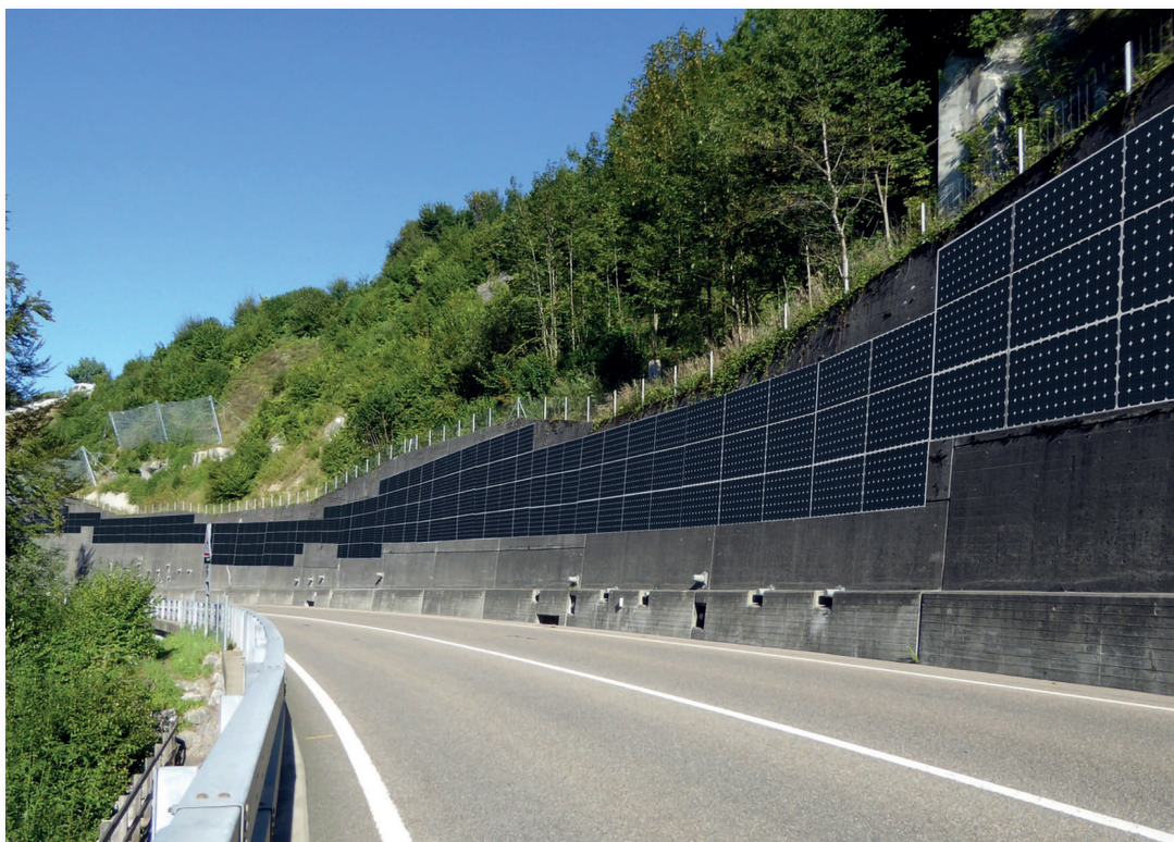
Muro fotovoltaico de 325 kilovatios de potencia en Ausserrhoden (Alemania)
