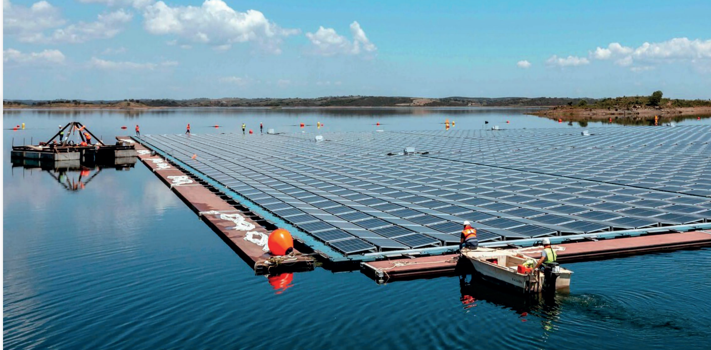
Parque solar flotante de 5 MW, en el embalse de Alqueva (Alentejo, Portugal), cerca de la frontera con España
