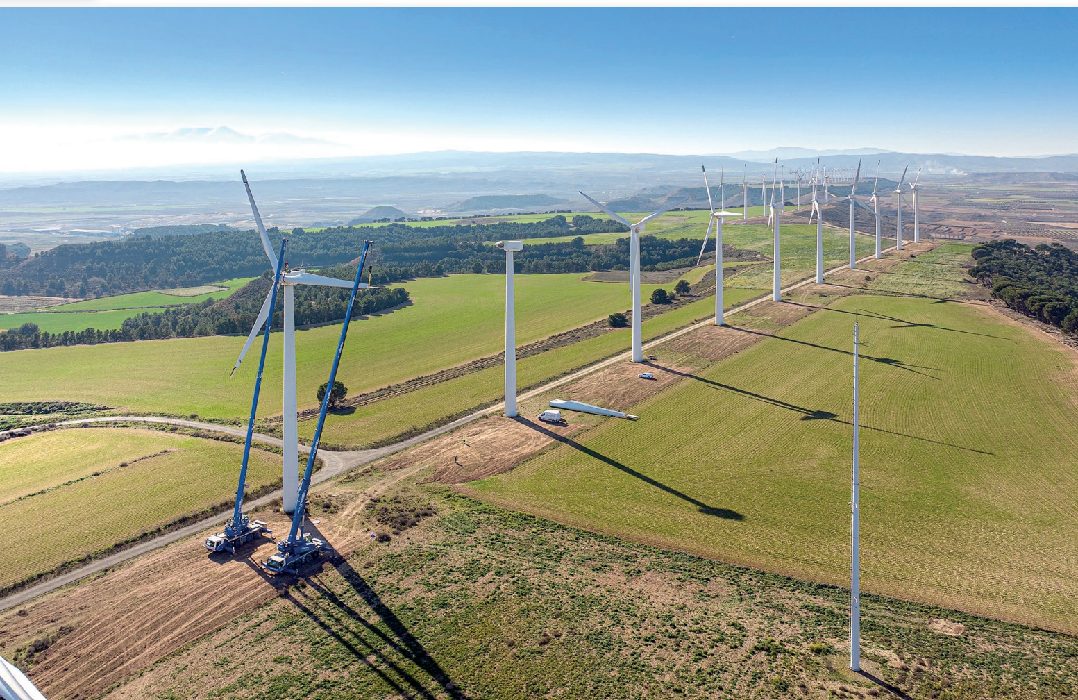
Trabajos de desmantelamiento en el parque eólico de Montes de Cierzo, en Navarra
