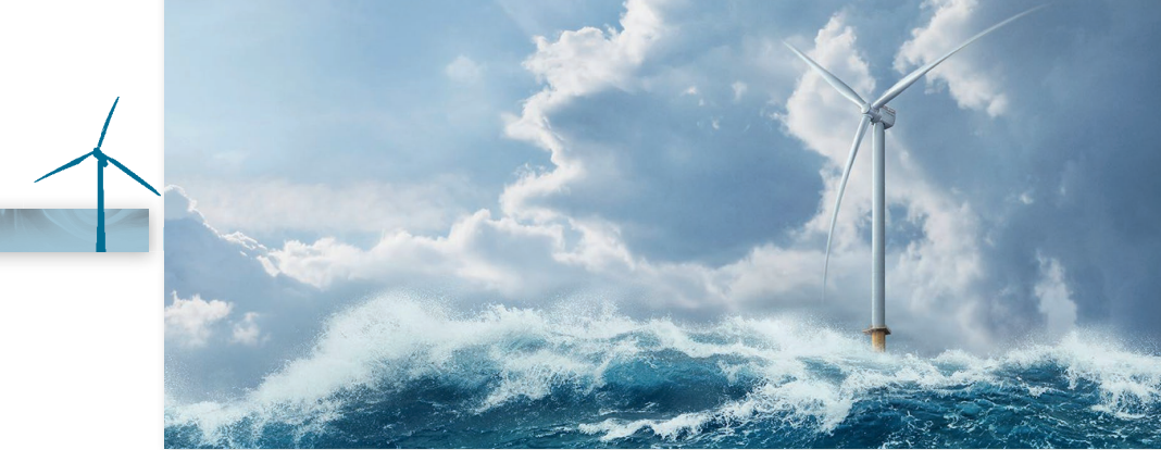
Aerogenerador marino de 14 MW de Siemens Gamesa, uno de los más grandes del mundo
