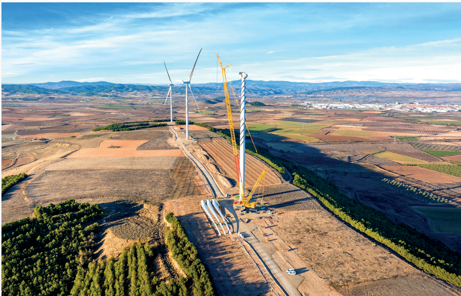
Montaje de palas de los nuevos aerogeneradores.
